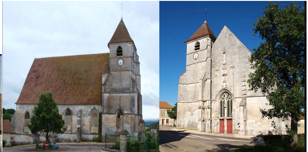
Église Saint-Martin de Taingy construite au XVI e siècle
